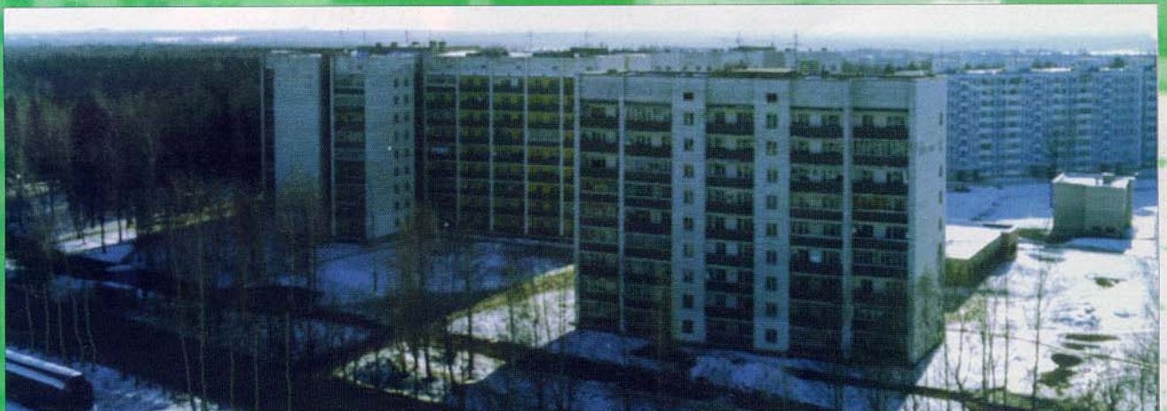
Новостройки Новостройки. Erection of new houses
