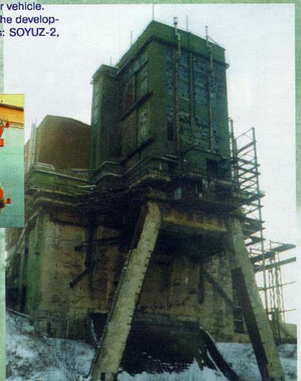
Стенд испытательной станции ИС-102 Stand of Test Station 102
